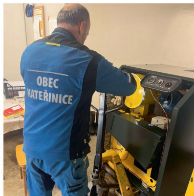
výměna dmychadla na ČOV
