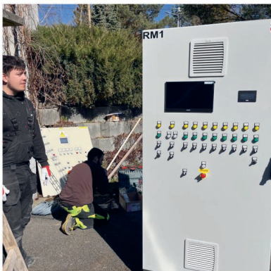
modernizace technologií ČOV
