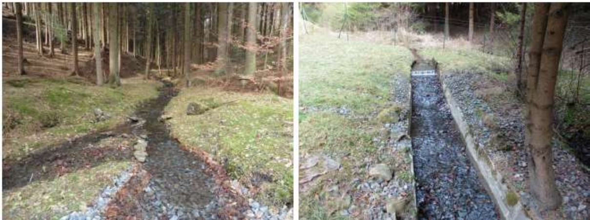
Foto jímacích zářezů surové vody na potocích při běžném průtoku
