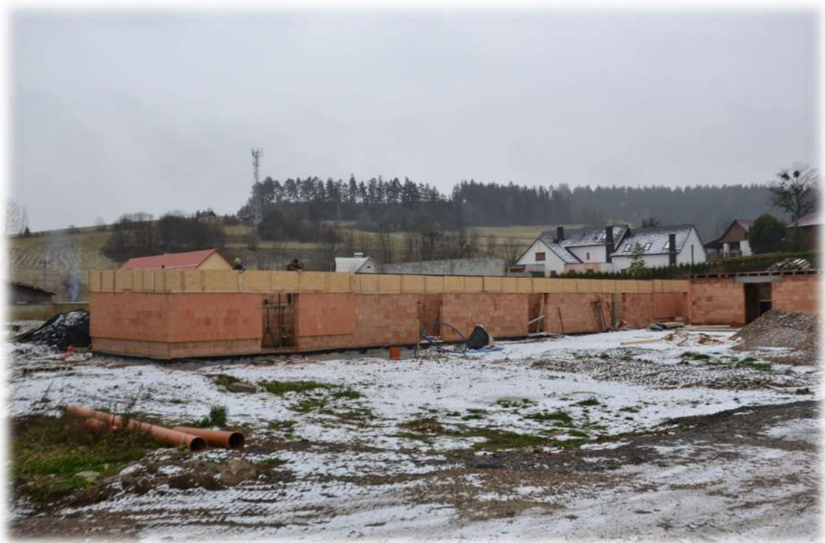
Stavba bytového domu Kateřinka
